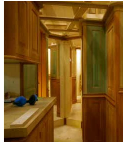
Een doorkijkje in het voorschip. Panelen die later worden geschilderd, worden gemaakt van speciaal mdf dat onder extra hoge druk is verlijmd en dat weer op panelen wordt verlijmd om trekken te voorkomen. Op de foto's zien we hoe de betimmering vorm krijgt
